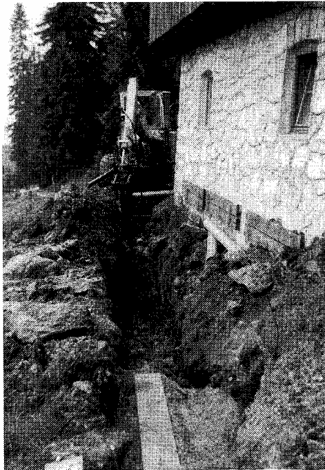
Bau der Kläranlage 1985
