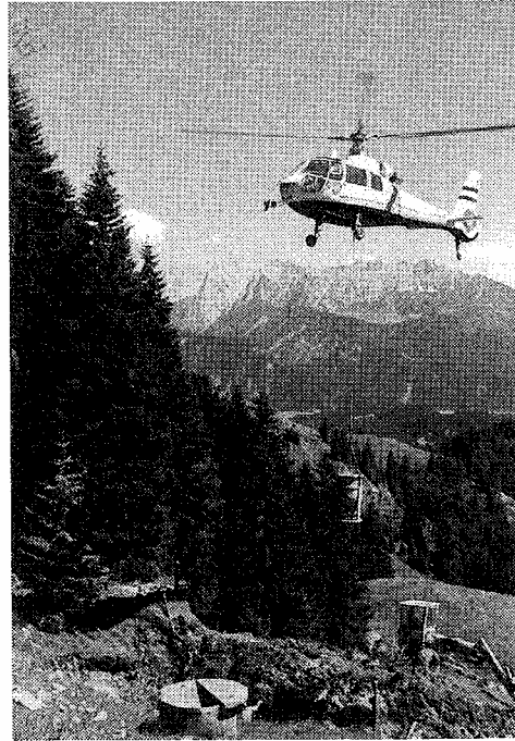
Hubschrauber bei der Erweiterung der Wasserversorgung 1985
