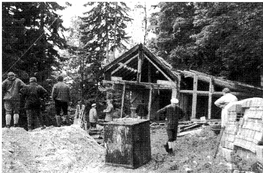
Abbruch des Pferdestalles
