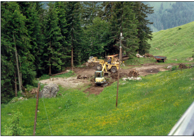
Der Bauplatz wird vorbereitet
