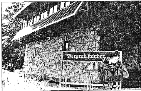
Am Salettl werden die Sonnenstrahlen für die Stromversorgung eingefangen.
