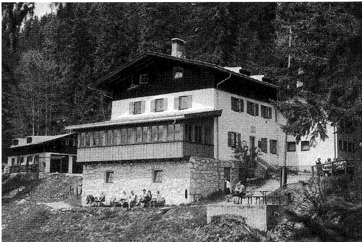
Das „neue“ Brunnsteinhaus nach Abschluß der Modernisierungsarbeiten (Aufnahme 1982)
